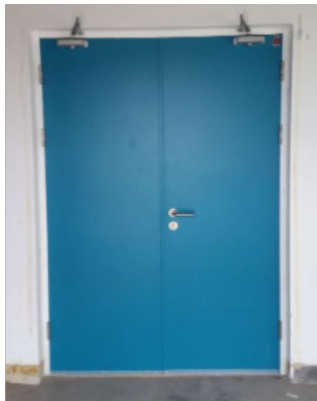
轩源防火门：1、判定依据：《防火门 GB12955-2008》2、轩源防火门按耐火性能的分类及代号：3、和防火玻璃、防火窗、防火卷帘不同的是，通常情况下，我们很少使用部分隔热（B类轩源防火门）和非隔热（C类轩源防火门），都是使用同时满足耐火完整性和耐火隔热性要求的隔热型（A类），其中常用的是甲级、乙级、丙级轩源防火门。为响应国家政策号召、满足市场需求，中窗认证迅速反应，对相关国家标准、行业标准、地方标准及门窗防火数据展开了调研，经过研究、讨论、验收及备案等环节，完成了CZC-GZ01009-2019《防火窗产品质量认证实施规则》的研发。门芯强度包括抗裂强度和抗弯强度。抗裂强度高可以保证其在运输过程中不易破碎，如果门芯板出现裂缝或破碎无疑是致命性的，会造成门扇局部或整体超温，影响轩源防火门的隔热性能。解决方法：增大门芯密度和强度，在门扇内加龙骨。
